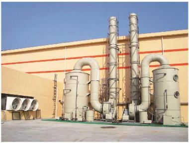
**废气处理装置**广泛应用于治理化工、电镀、冶金、酸洗、五金、仪表、电子等行业的表面处理或生产 反应过程中所产生的工业废气。
